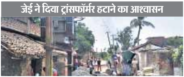
सड़क पर गाड़ा हुआ ट्रांसफॉर्मर का पोल।
